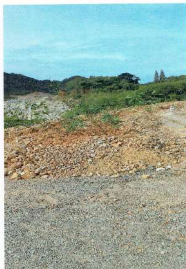
รูปที่ 4 ทำคันทำนบดินเพื่อการปรับสภาพและฟื้นฟูระบบป้องกันการชะล้างตะกอนดินจากบริเวณหน้าเหมือง
