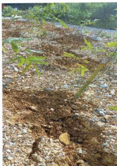
รูปที่ 4 ทำคันทำนบดินเพื่อการปรับสภาพและฟื้นฟูระบบป้องกันการชะล้างตะกอนดินจากบริเวณหน้าเหมือง
