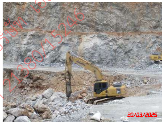
รูปที่ 23 เครื่องเจาะระเบิดแบบดินตะขาบและเครื่องเจาะกระแทกหิน
